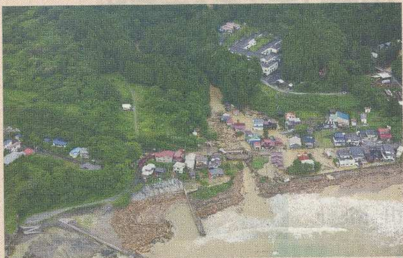
2021年8月10日から青森県内で降り続いた大雨によって、下北地域を中心に多くの被害が発生した。大赤川と小赤川の両方から泥水が流下し、特に小赤川から大量の流木が流出した。また、国道279号の小赤川橋が落橋したほか、橋には流木が多数捕捉されている。さらに、土砂が周辺人家まで到達している様子も確認できる(青森県むつ市) (撮影:アジア航測、朝日新聞)
